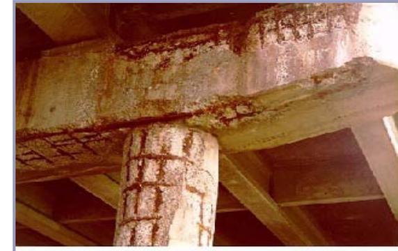
Рисунок 12. Разрушение опор моста
