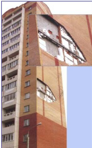
Рисунок 13. Обрушение фасада дома вследствие коррозии стальных гибких связей
