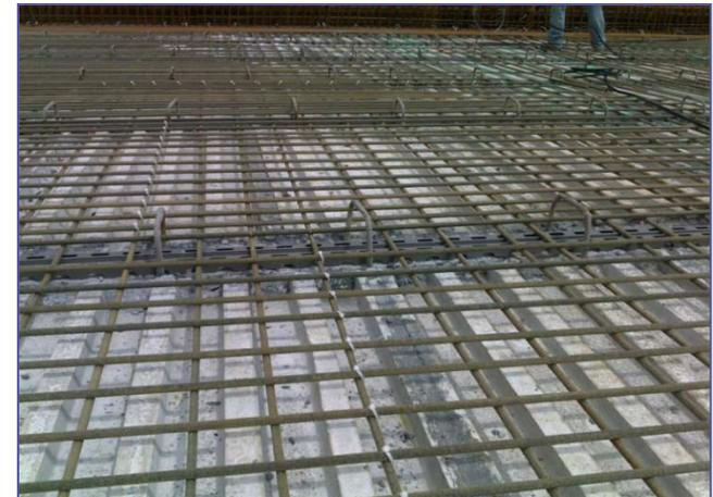
Рисунок 8. Стержни «RockBar» в настеле нового моста в Co. Fermanagh, Северная Ирландия
