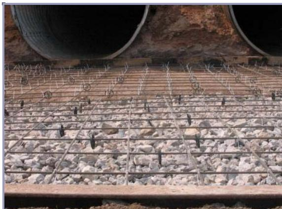
Рисунок 10. Сетка из композитных стержней
