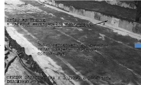
Бетонная подготовка наносится в плоской форме
