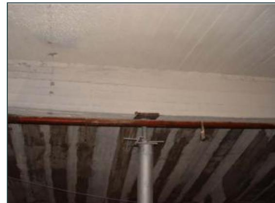
С помощью углепластиковых накладок была обеспечена несущая способность целого ряда бассейнов в поселках Горки, Кедр-2 Московской обл. Также были разработаны технические решения и выполнено усиление спортивных бассейнов в г.Обнинск и Пермь. Технология внешнего армирования композитными материалами при ремонте чаш бассейнов обеспечила повышение их жесткости, трещиностойкости и несущей способности, тем самым создавая благоприятные условия для надежной гидроизоляции бассейнов.
