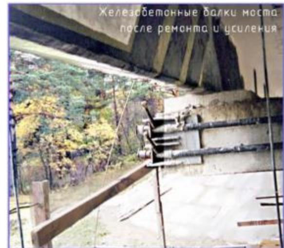
Совместно с УНР-494 были выполнены работы по ремонту и усилению железобетонных балок пролетом 16,7м. В балках имели место отслоения защитного слоя с оголением и коррозией арматуры, раковины, каверны. Усиление выполнено путем наклейки углепластиковых накладок из 3-х слоев ткани по нижнему поясу балок, наклонных хомутов из 2-х слоев ткани на опорах и вертикальных хомутов из 1-го слоя ткани в пролетной части.
