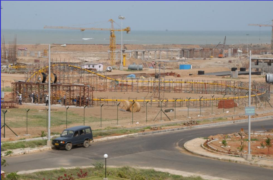
Mock up for helicoïdal tendons
