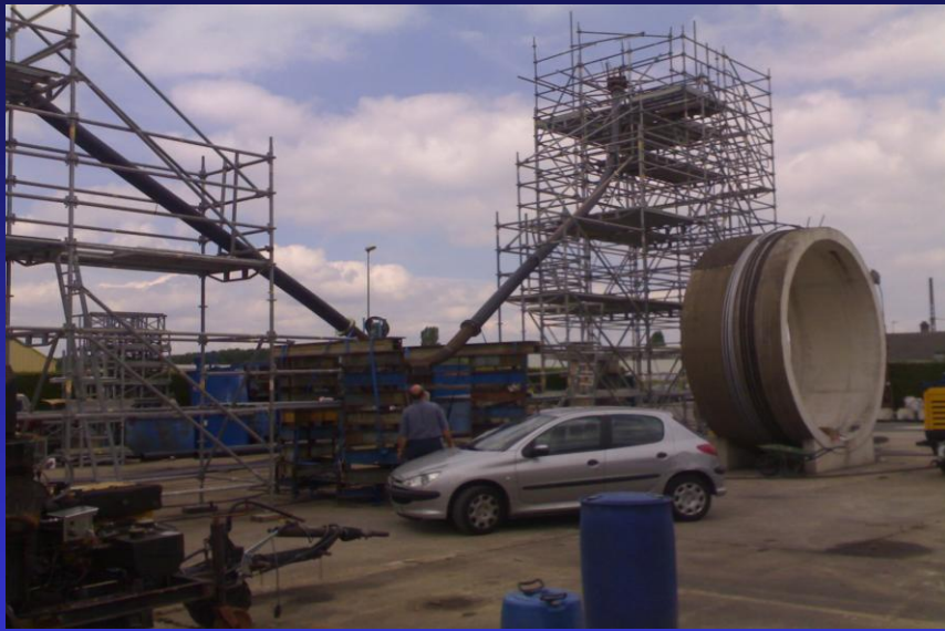
Mock up for helicoïdal tendons
