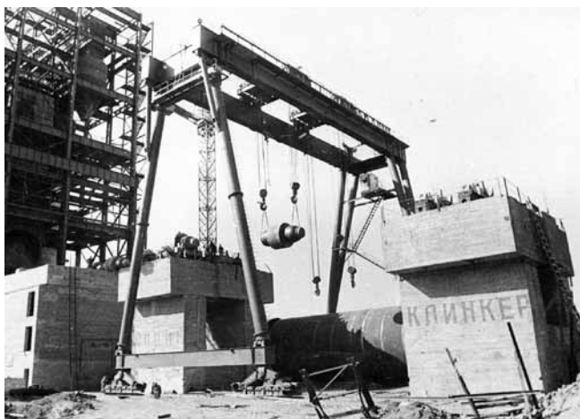
КОЗЛОВОЙ КРАН КМК-200, ГРУЗОПОДЪЕМНОСТЬ 200Т
