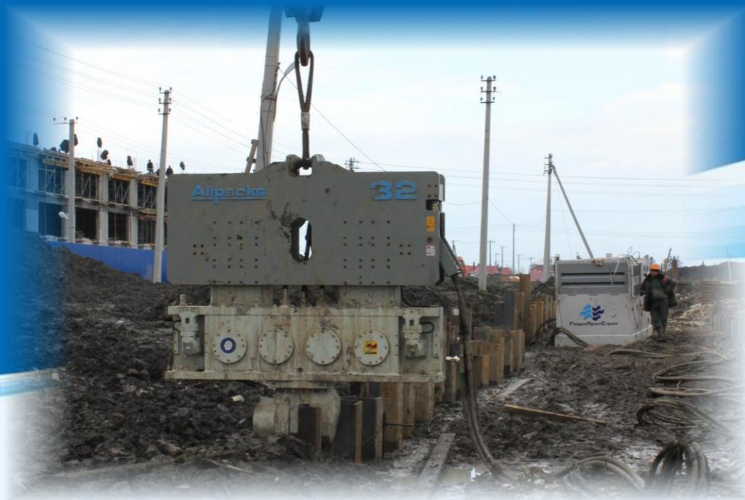
**Основной недостаток вибрационного погружения - производимый шум и относительно высокий уровень колебаний, что ограничивает возможности применения вибропогружения вблизи существующих строений.**
