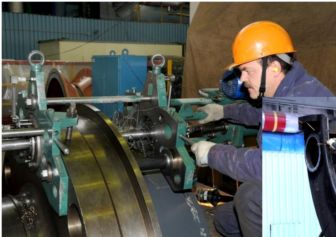
Райберовка полумуфт роторов турбин
