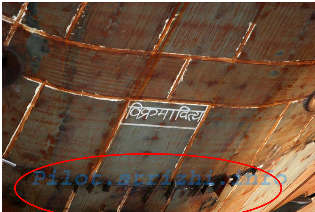
Монтажный стык корпуса корабля Викрамадितью «вверху»
