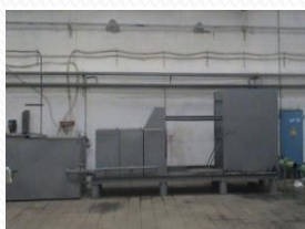
Ремонт сосудов, теплообменников
