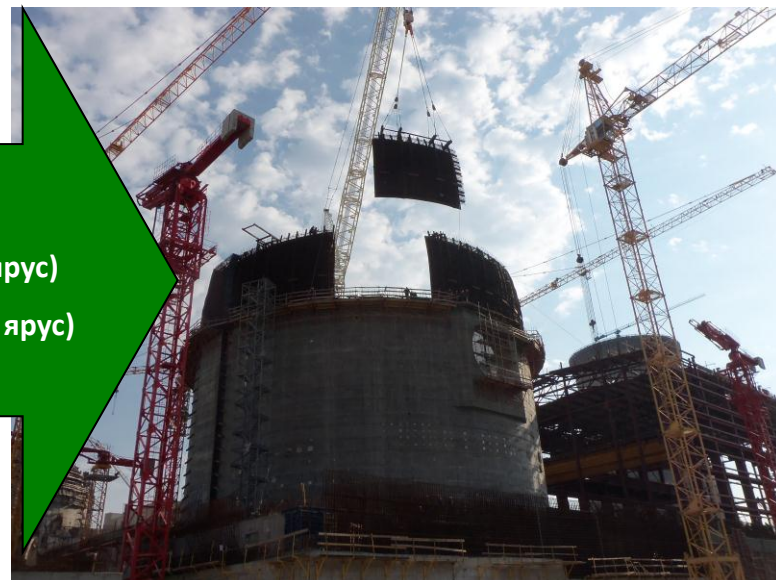
График монтажа УБМ (4+5 ярус) с отм. 34,42 до отм. 44,10 здания 20УИА
