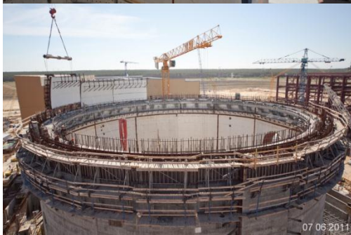
энергоблок №2: параллельное изготовление укрупненных армоблоков 4-го и 5-го ярусов
