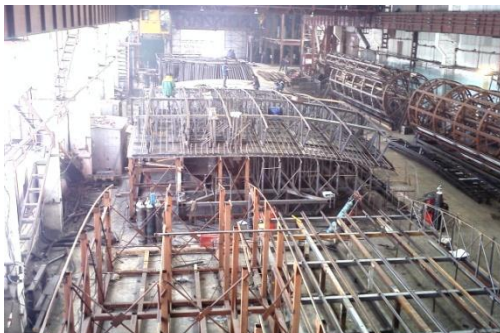
энергоблок №2: параллельное изготовление укрупненных армоблоков 4-го и 5-го ярусов
