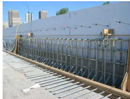
Рис.4. Барьер моста, Канада
