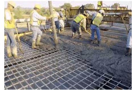
Рис.2. Строительство моста, Канада
