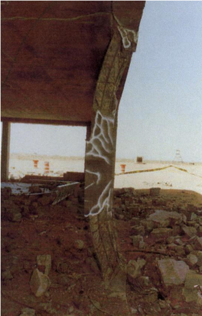
Не усиленная колонна
