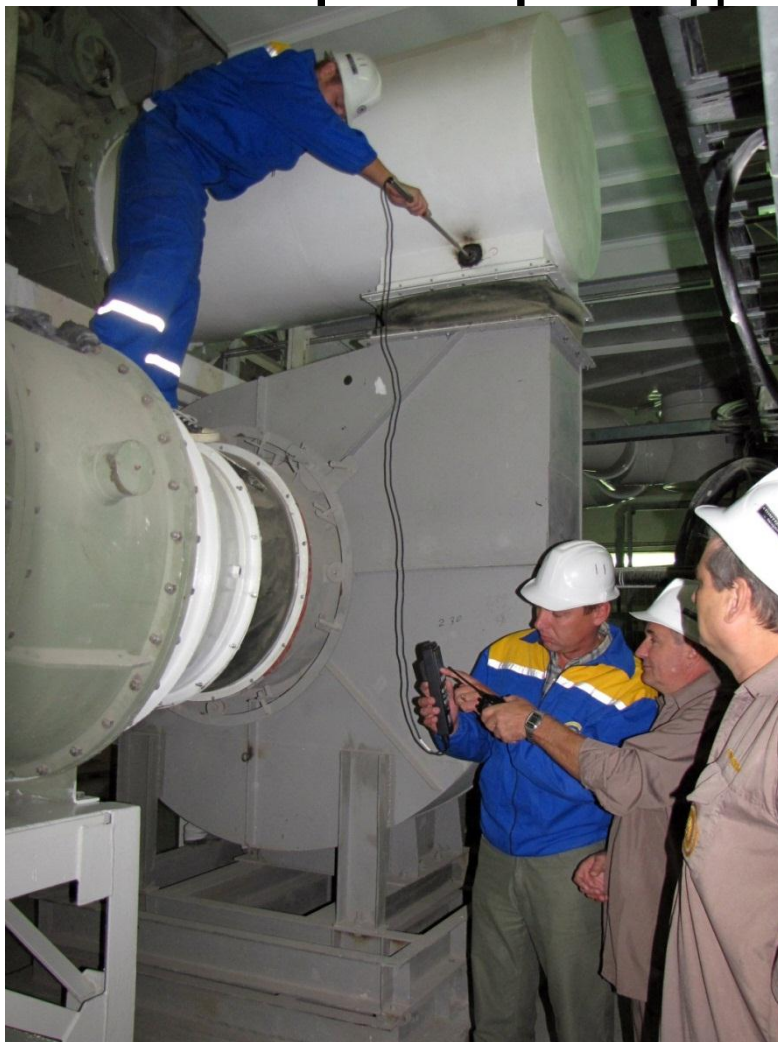
Рис. 10 Проведение измерений на вентсистеме АЭС «Бушер»
