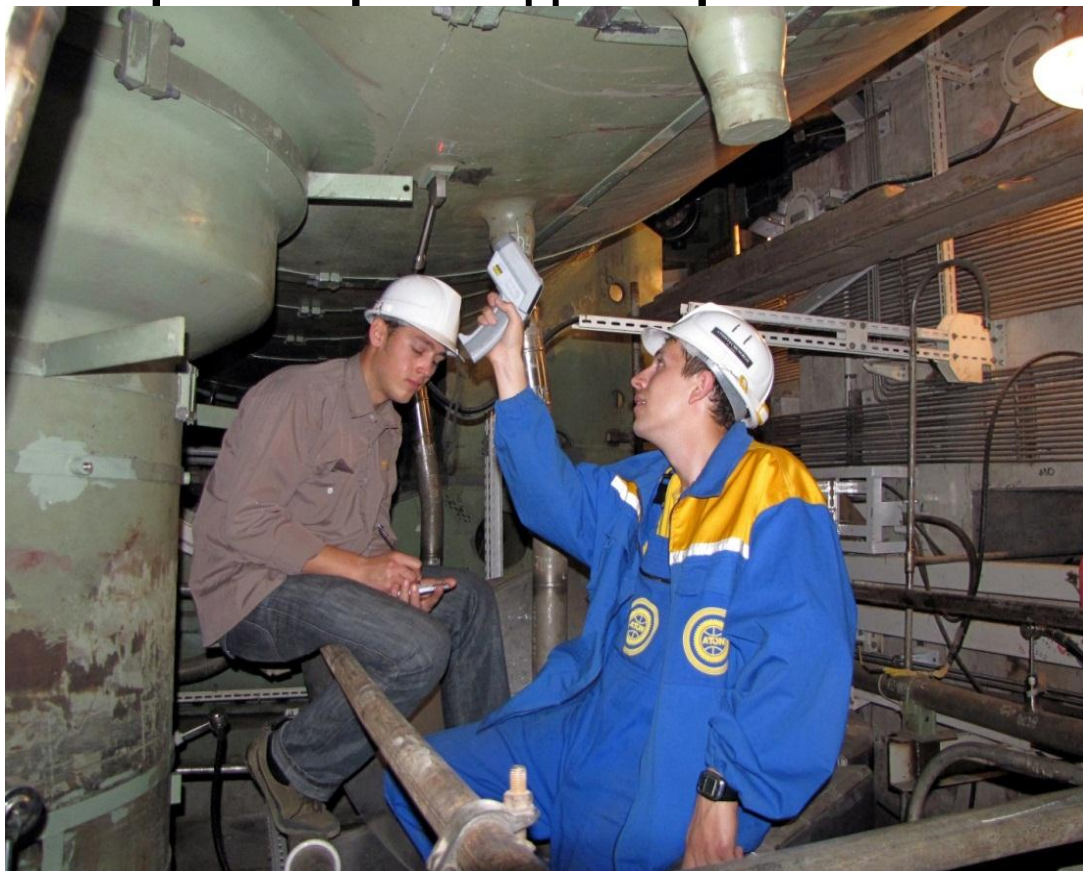
Рис.9 Термометрирование наружной поверхности парогенератора АЭС «Бушер» с помощью инфракрасного термометра
