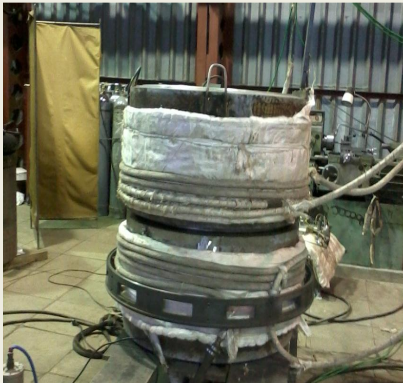
Контрольное сварное соединение ГЦТ, подготовленное под сварку
