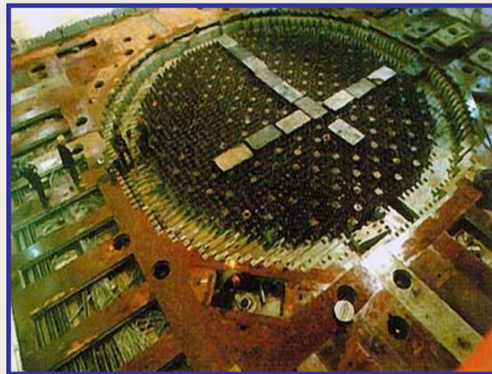
Монтаж 2-го блока Игналинской АЭС
