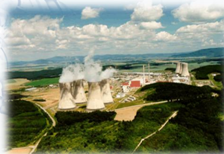
АЭС «Моховце», Словакия
