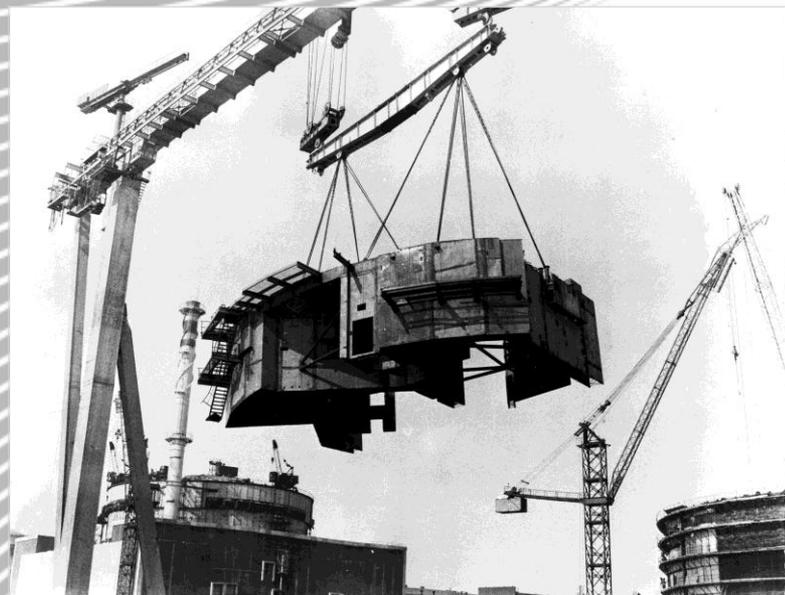
Монтаж козловым краном модуля гермозоны весом 200 т.
