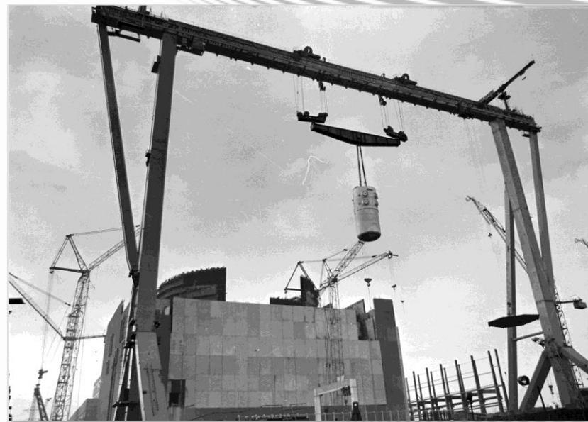
Монтаж корпуса реактора по методу «открытый верх»
