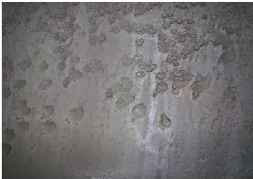
Корпус абсорбера после года эксплуатации без защитного покрытия
